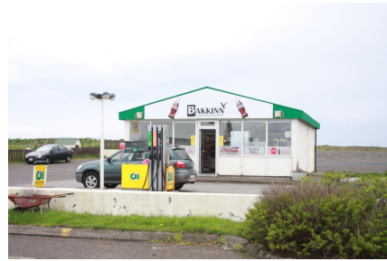
Bensínstöð, júlí 2017. Norðurhlöð.
