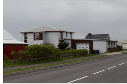
Staðarbakki, júlí 2017. Austurhlíð
