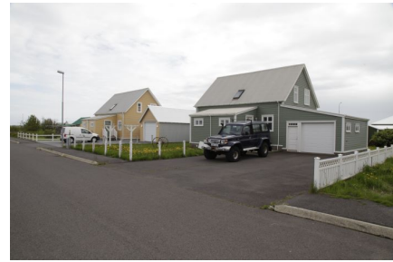
Þykkvaflöt 6, júní 2017. Norð- vesturhlöð.
